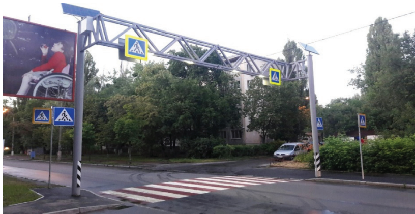
Рисунок 10 – Використання портальної конструкції на вул. Академіка Туполева (м. Київ) Figure 10 – Use of portal construction on the street Academician Tupolev (Kyiv)
