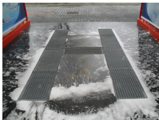
Rys.15. Płyta stanowiska z kratkami ściekowymi [11]
